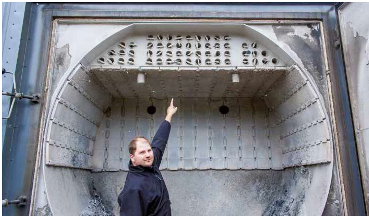
Røgrørene øverst i fyret skal renses hver 14. dag. Ellers er der ikke meget vedligehold.
